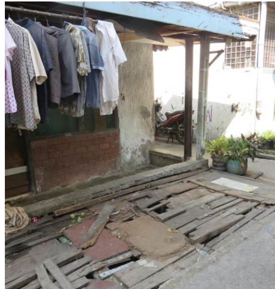
Holzbretter vor dem Haus
